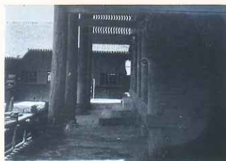
正殿・唐破風向拝柱側面
