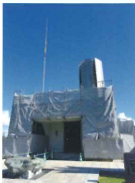
③正面養生シート取付工事のようす
