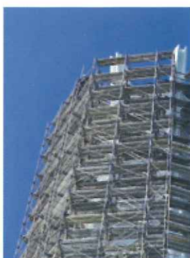
⑥足場解体工事のようす
