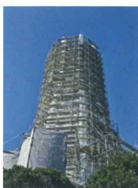
⑤正面東側より足場撤去工事のようす
