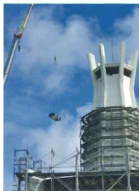
①正面足場組立工事のようす
