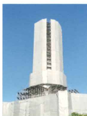
④西側より養生シート取付工事のようす
