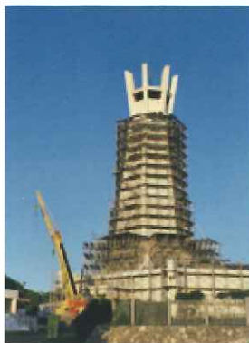
②西側より足場組立工事のようす
