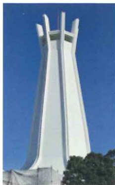
⑦上部防水塗装工事完了
