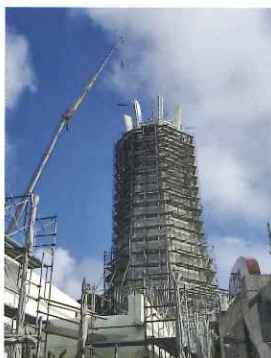
改修工事の様子（9月撮影）
